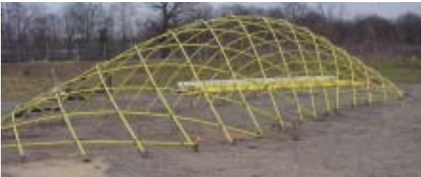
► [figure 5] Vue d'ensemble de la structure
