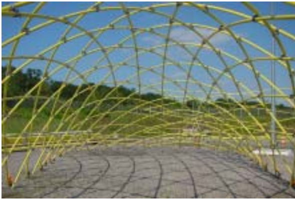
► [figure 4] Intérieur de la structure contreventée
