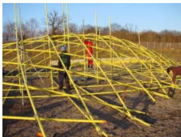
► [figure 3] Vue du montage au moyen d'étais remontés à la main
